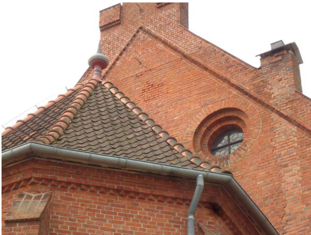
9. Widok zakrystii od strony wschodniej dachówka ceramiczna esówka, blacharka do wymiany.
