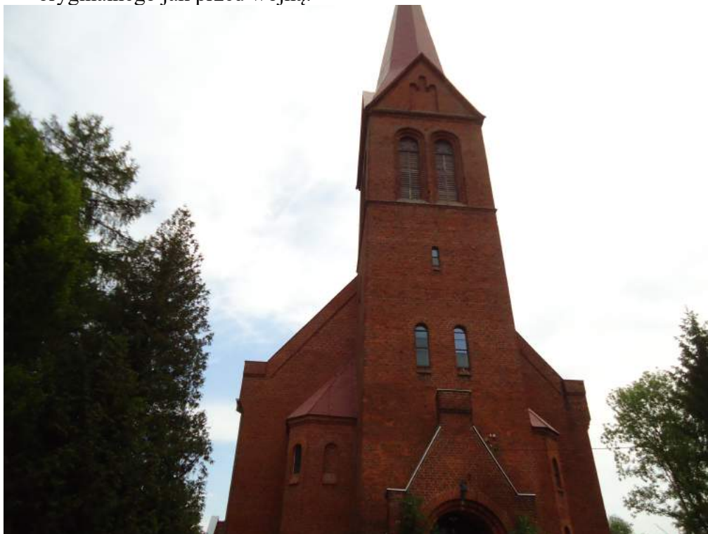
19. Widok kościoła od strony zachodniej, przybudówka wymienić pokrycie z blachy stalowej ocynkowanej malowanej na dachówkę esówkę powrót do pokrycia oryginalnego jak przed wojną.
