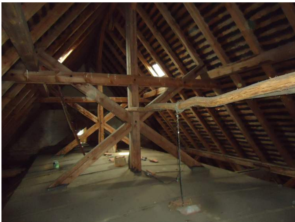
36. Widok konstrukcji dachowej perespektywa więźby dachowej.
