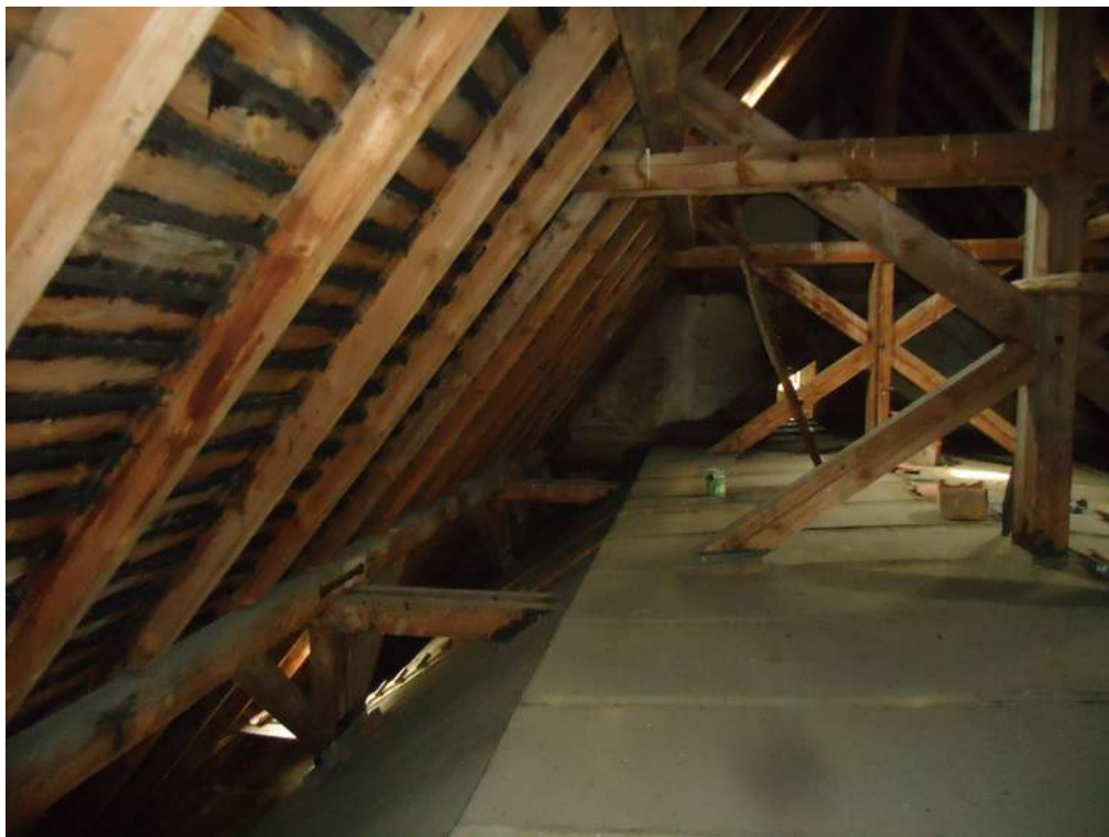
35. Widok konstrukcji dachowej perespektywa więźby dachowej.
