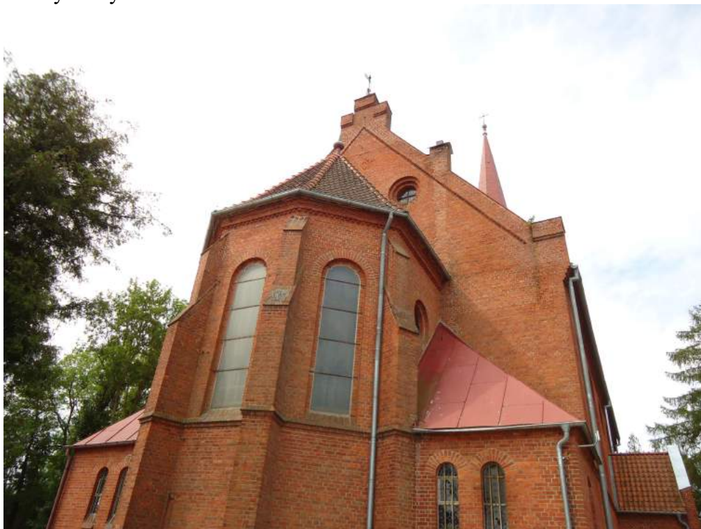
9. Widok zakrystii od strony wschodniej dachówka ceramiczna esówka, blacharka do wymiany.
