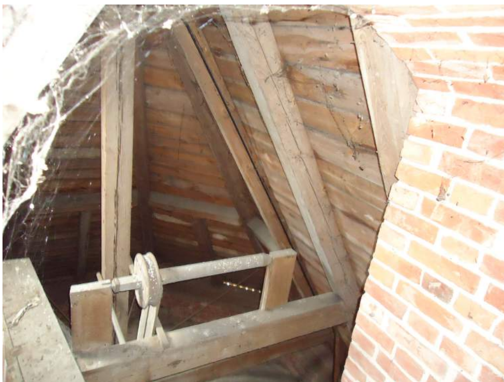
46. Widok zakrystii konstrukcja drewniana do remontu, deskowanie do wymian
